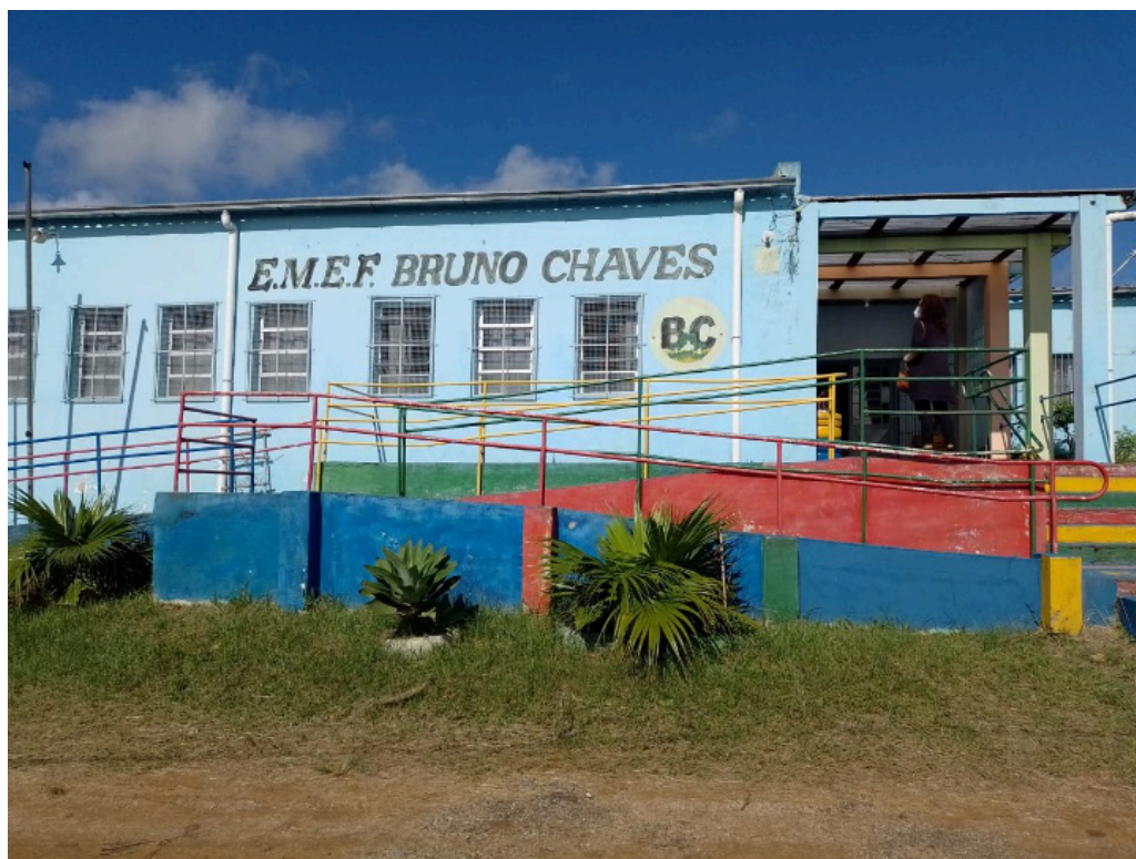
Figura 1 - Entrada da Escola Municipal de Ensino Fundamental Bruno Chaves. Fotografia: Maria Mayer de Mattos, 2022.
